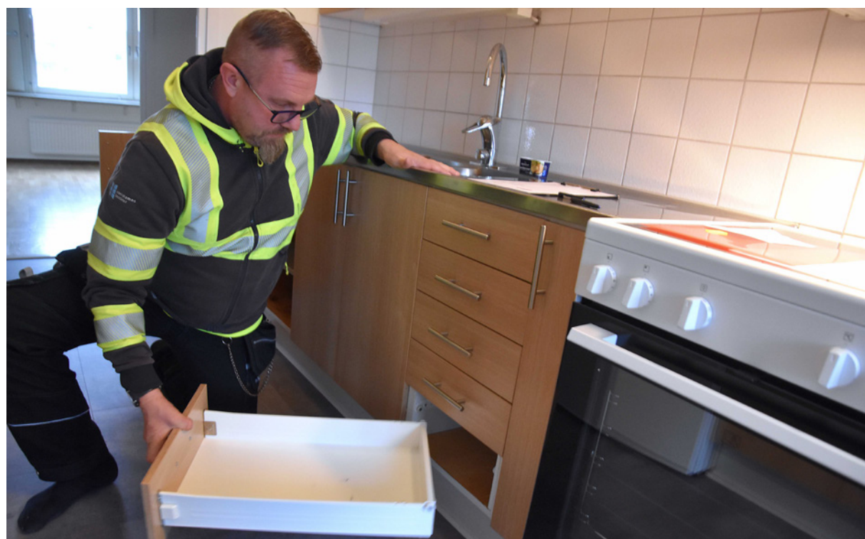
Rickard Andersson är noggrann när han slutbesiktigar en lägenhet. Han drar exempelvis ut alla kökslådor för att kontrollera både att lådorna i sig är städade och att det inte är smutsigt bakom dem.
